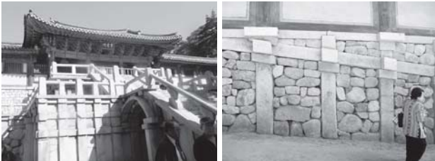
B: 慶州仏国寺 青雲橋・白雲橋。石段を「橋」と呼ぶのは、俗世と仏国土である「釈迦如来の彼岸世界」を結ぶという意味だそう。石釘を用い、階段・アーチが、細く、薄く、組み立てられている。石の柱に自然石を埋めるなど、日本と異なる石の構造を見る。(写真:O, I)
