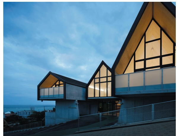
武松幸治氏設計のこどもの森保育園全景 屋根と床にCLTを使用している (写真 Nacása & Partners)
