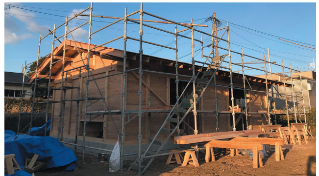
<小さな家づくり>渡り腰+落とし込み板壁構法による復興住宅モデルハウス
