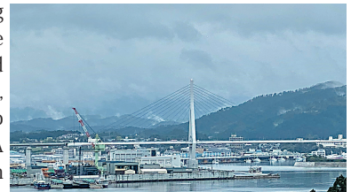
イ：気仙沼湾を大きくまたいでいる三陸自動車縦貫道の気仙沼かなえ大橋
