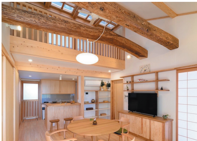
被災した納屋の梁を再利用した「くまもと型復興住宅」
