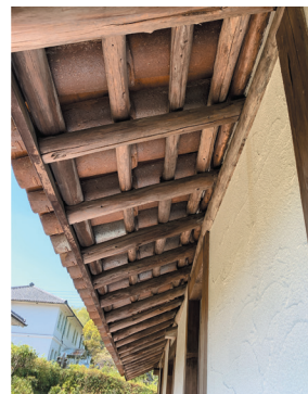
ブラジル移民住宅の軒天井
