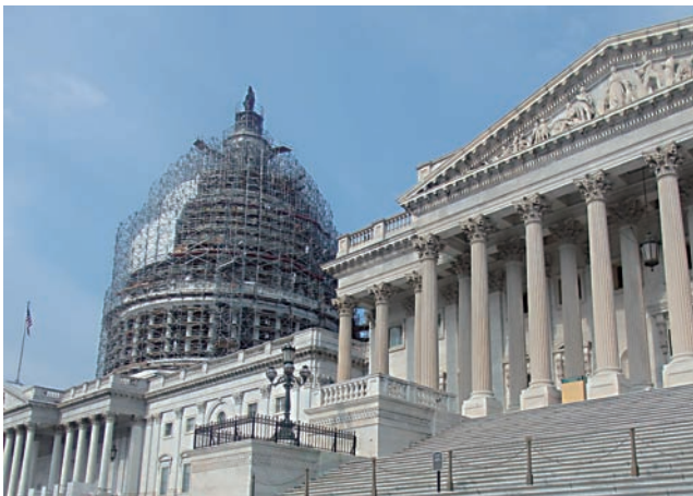
連邦議事堂に近づくー改修工事中のドーム頂部に自由の像（写真：宮本）
