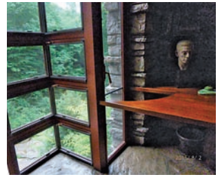
C: 階数を感じさせない見事なサッシ割り。内開き網戸の軌跡に合わせて割り貴かれたデスクが印象的。
