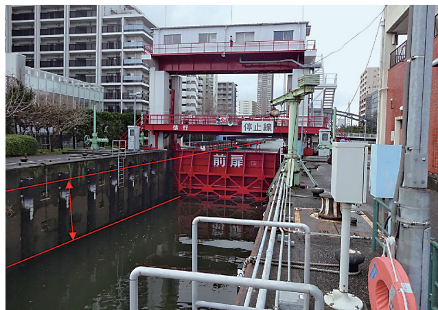
扇橋閘門の閘室側（東地域の水位）から、隅田川側（西地域の水位）を望む。 *赤いラインで約2mの水位差を示す。
