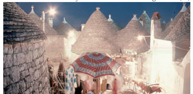
南イタリアのアルベロベッロの町に建つトルツリ。古代ギリシャと同じ持送りによるドーム型屋根で、雨水を集める仕組みになっている。(写真:斎藤公男 1993 撮影)
