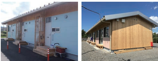
坂茂氏設計の御船町東小坂仮設団地：木製格子で給湯器、室外機やメーター等を囲い、手摺り・表札・郵便受けを取付けたり、木の階段を設置するなど色々な表情がある。基礎がH鋼だった。(写真左：稲垣、写真右：井出)
