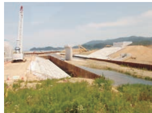
しかし、その商店街周辺はまだ工事風景が広がる (写真: 岩井紘子)
