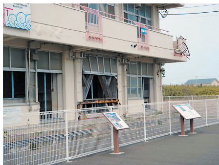
震災遺構として一般公開されている仙台市立荒浜小学校の1階部分 (写真: 岩井紘子)
