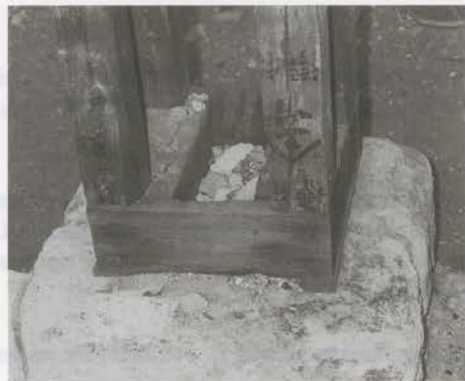
柱と土台の構造
