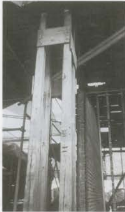
柱と界壁の構造
