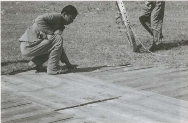
①たまたまりハビリテーションセンターの横で小さいゲルの組み立てが始まった。まず、床板を大地に敷く。これを定規に組み立てる。
