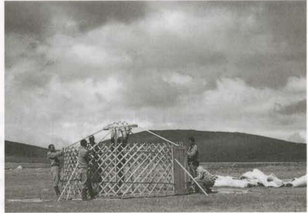
④組み立て中のゲルの遠景
