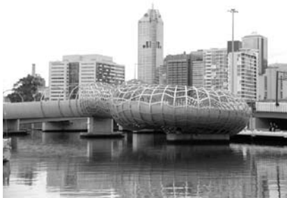
メルボルンの中心部を背景にした、「どくろ」のような浮かぶ歩道橋(デザイン: ロバート・オーエンとDCH)
