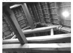
囲炉裏の煙でいぶされると茅の持ちが良くなる
