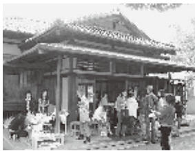
玄関。建物全体の床下にはコンクリートが敷きつめてあり、無窓で換気を選択できる。15cmの換気スリットがトイレと前室の壁面を一巡している。
