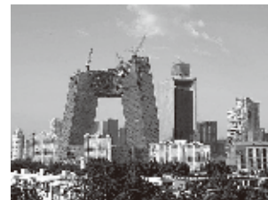
CCTV 本社ビル
