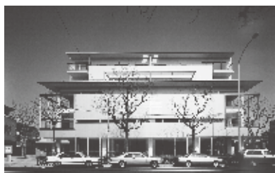
① 高さ10mのファサードラインで整えた外観
