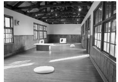
右：校舎2階の安田侃常設ギャラリー。天井ボードを外し、洋小屋組みを見せている。
