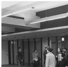
避難安全検証法により、高天井の煙だまりを設け煙降下時間を確保して内装制限を緩和した木質のオフィス空間 (撮影：井出)
