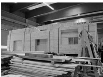
オーストリアの、接着剤を使用しないダボによる積層木造パネル。オーダーで17~38cm厚のパネルが制作されている (Thoma社)
