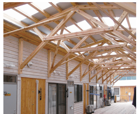
2011年7月23日遠野市、木造仮設住棟を対面式に配置し木組みのアーケードが繋ぐ。木造デッキは冬季の霜、降雪対策になっている。
