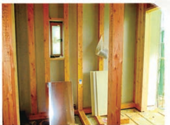
「蔵工法」の内部500ピッチで地元材柱が並ぶ
