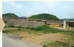
宮古市 田老旧防潮堤水門の惨状
