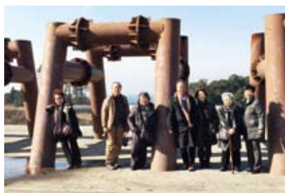
土石流が乗り越えた流木止めの鉄骨柵 (大島)
