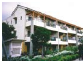
深沢環境共生住宅 世田谷区深沢
