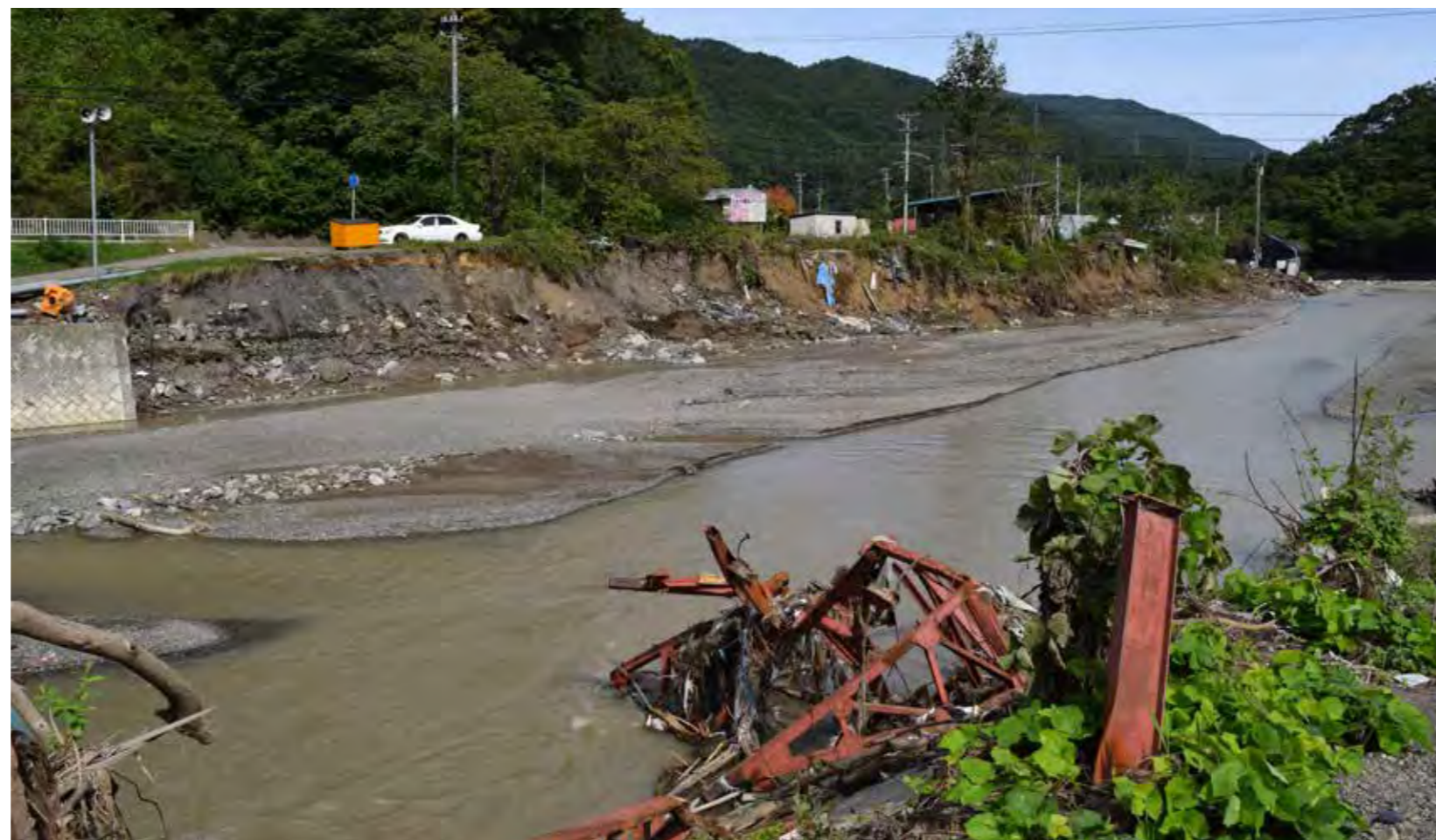
流れてしまった橋の残骸とえぐり取られた護岸が続く。橋だったはずの赤い鉄骨が打ち寄せられていた
