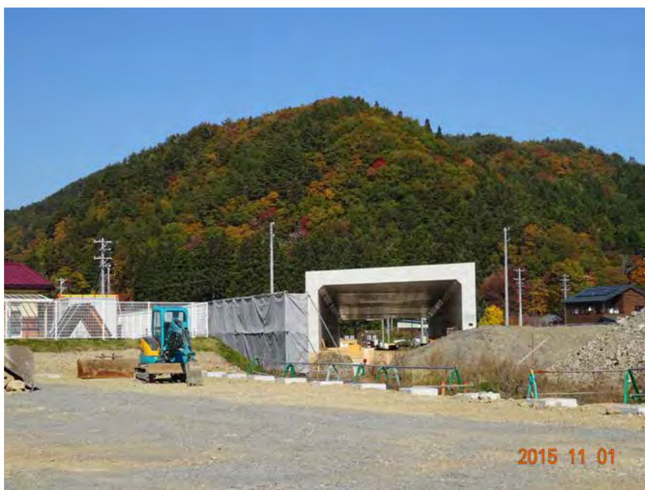
東北縦貫自動車道の工事も進む
