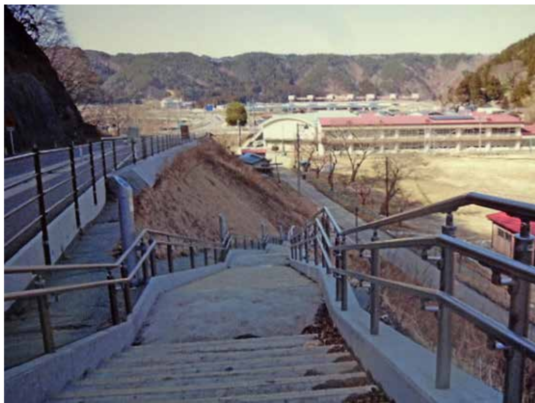
小本小学校からの避難路。この避難路は2009年に建設されていた。3.11には小学生たちはこの階段を使って避難した
