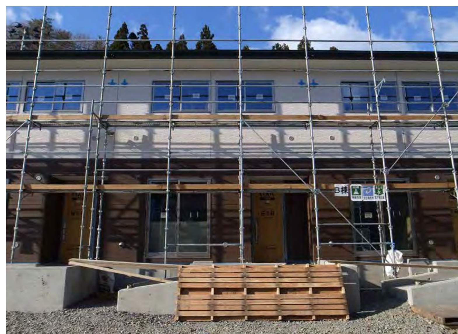
2階建森の越災害公営住宅も竣工間近。各玄関へのアプローチにスロープが設けられている
