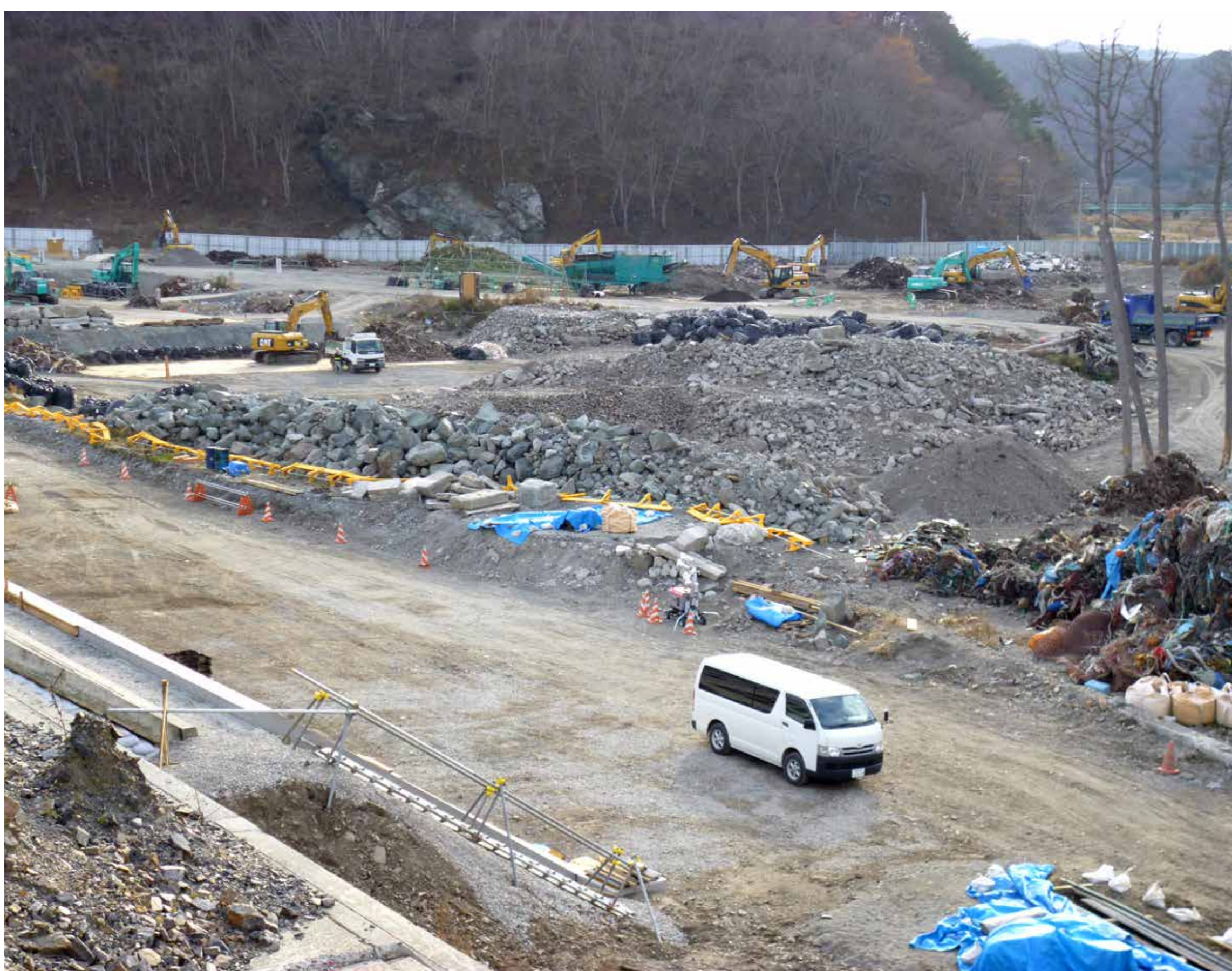
修復中の小本港
