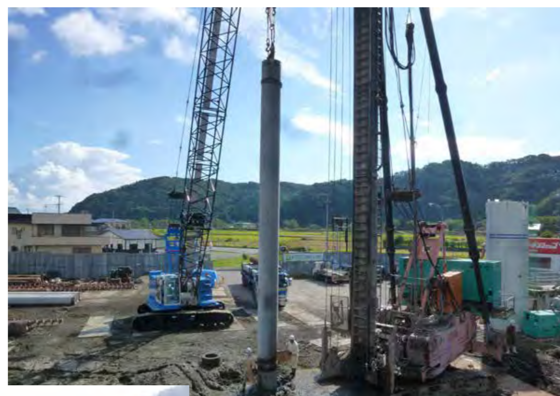
9月、コンクリート杭の打設機が入り、小本津波防災センターが着工
