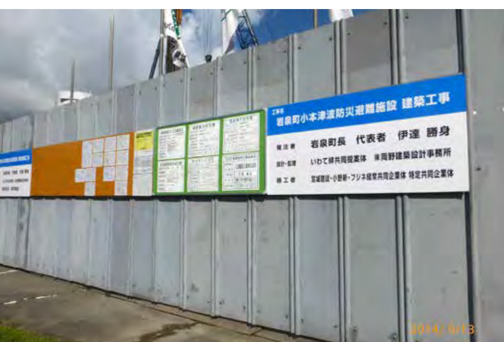
小本津波防災センターの工事看板
