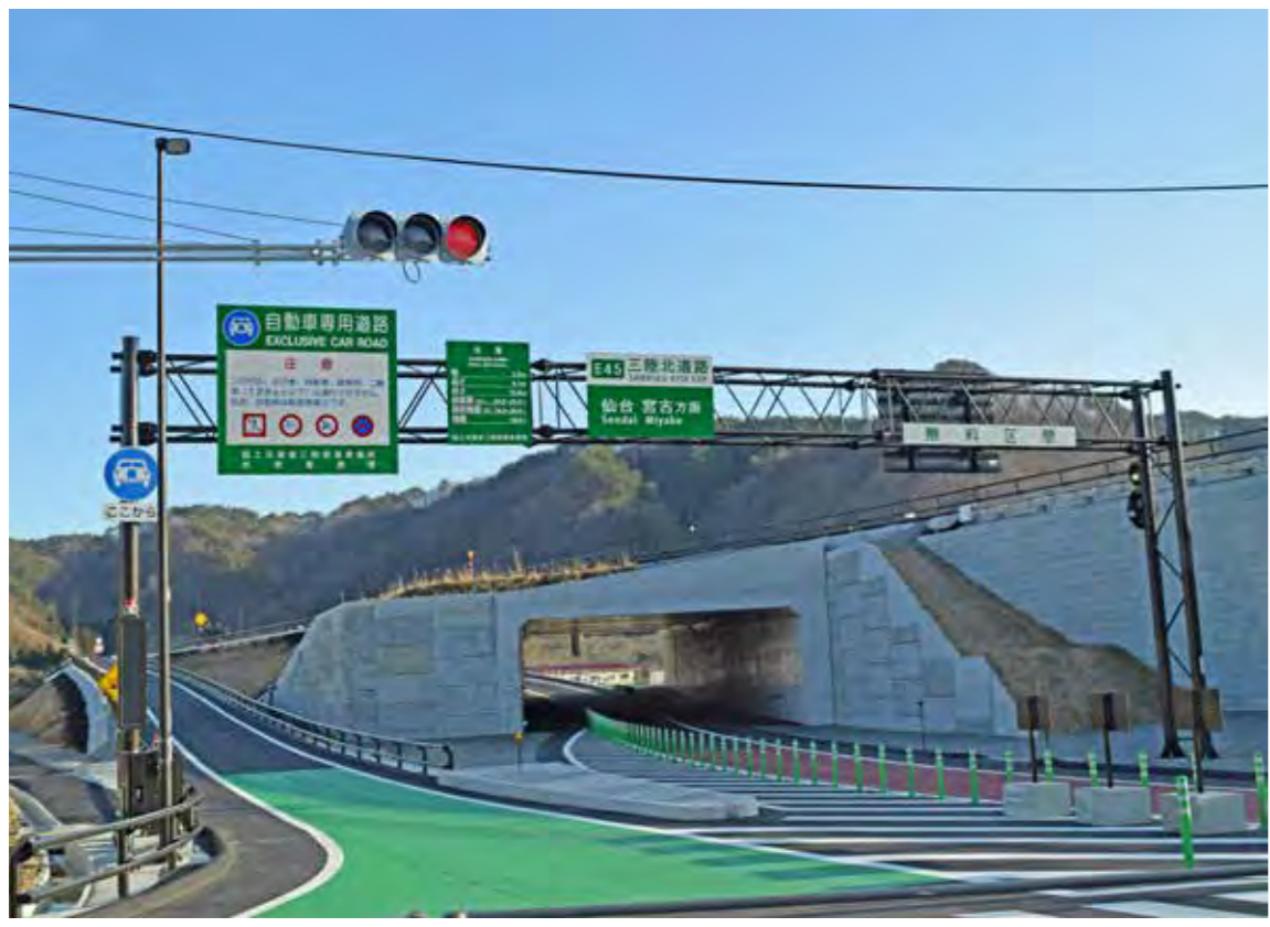
宮古 - 田老縦貫自動車道工事も着々と進む
