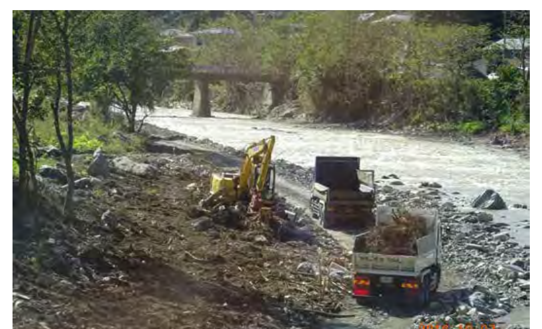
小本川河川敷に重機やトラックが入り始めている
