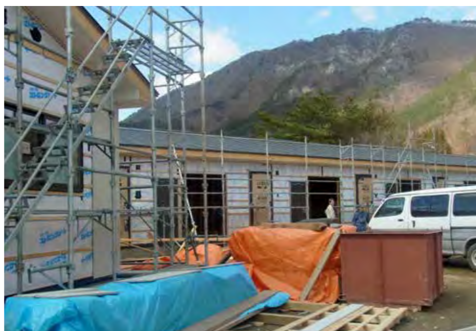
発災2年、災害公営住宅の建設が進んできた
