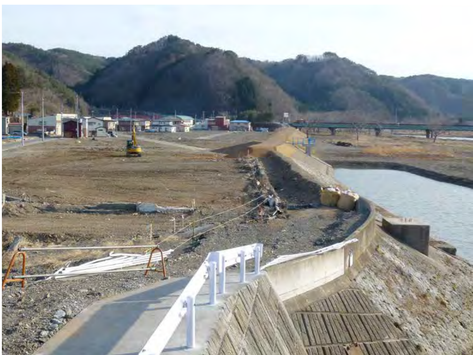
あちこちで復旧工事が始まっている
