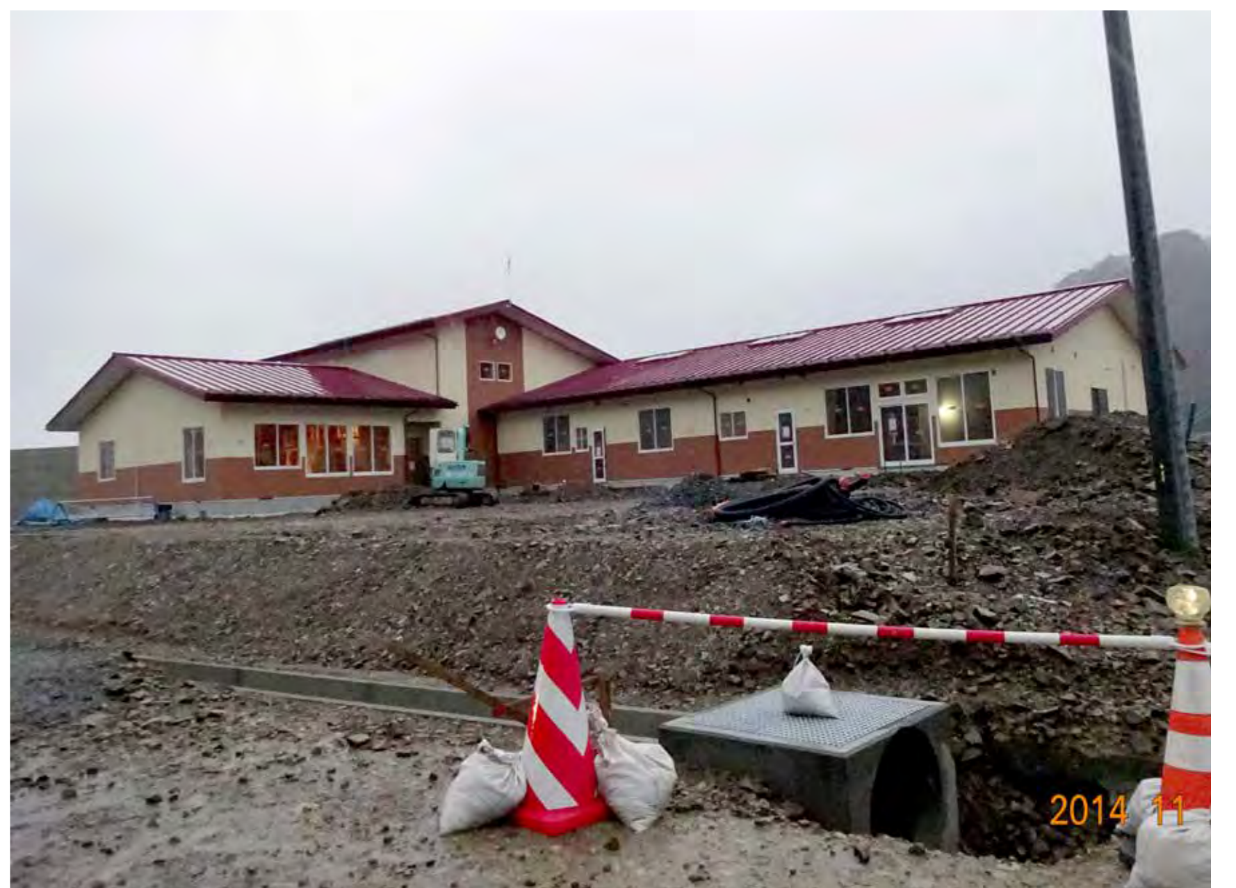
こども園も完成間近
