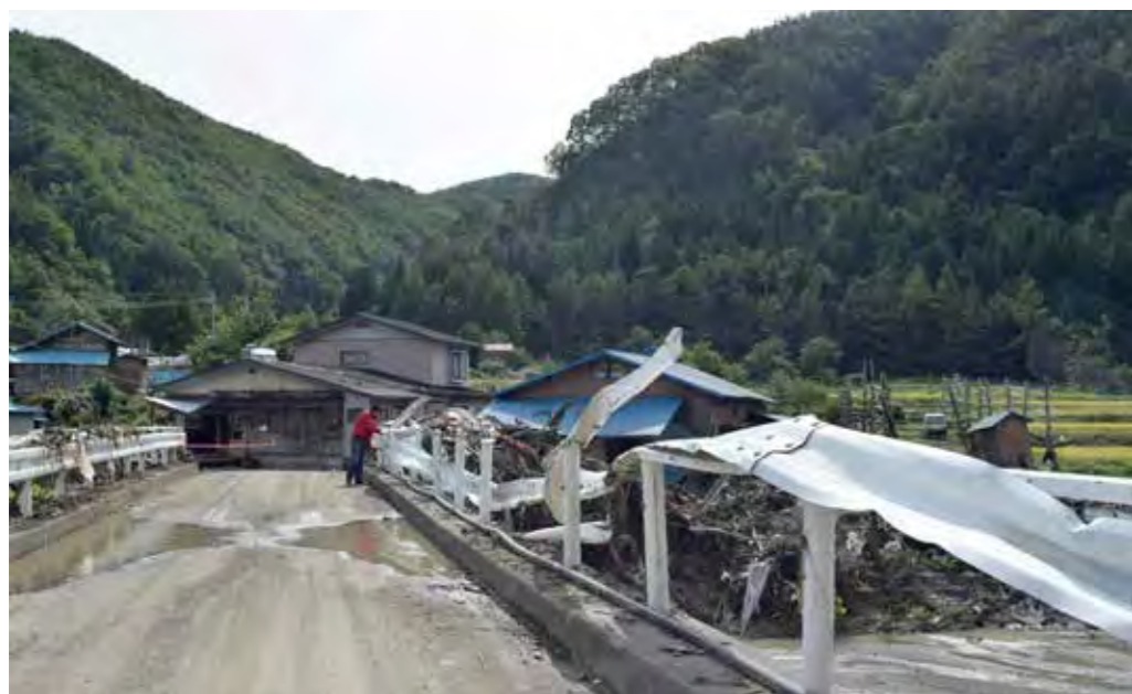
台風10号により破壊された橋のガードレールに瓦礫が引っかかる
