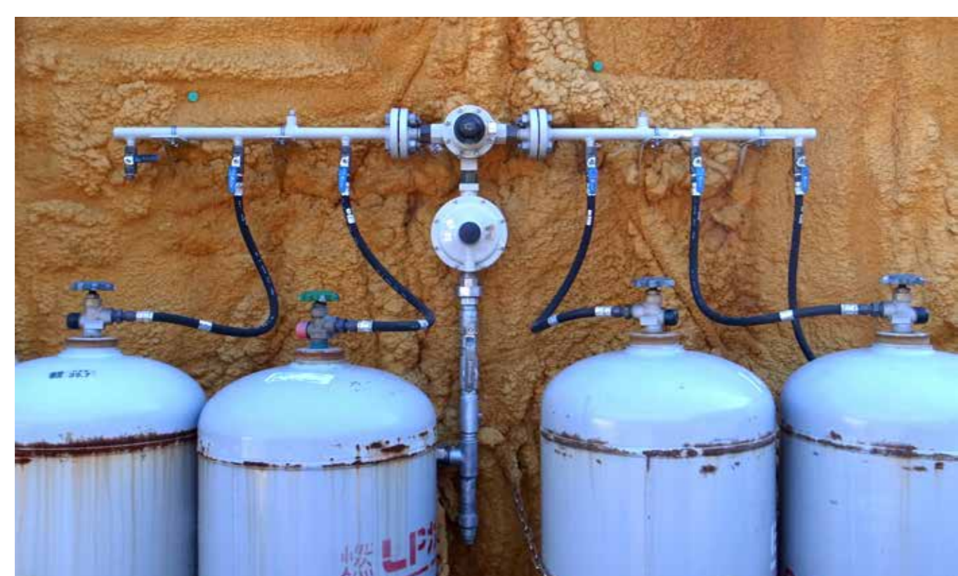
軽装備のプレファブ仮設住宅の外壁に、発泡ウレタンの断熱材が冬の寒さ対策として吹かれた。プロパンガスが住まいの熱源を支えている
