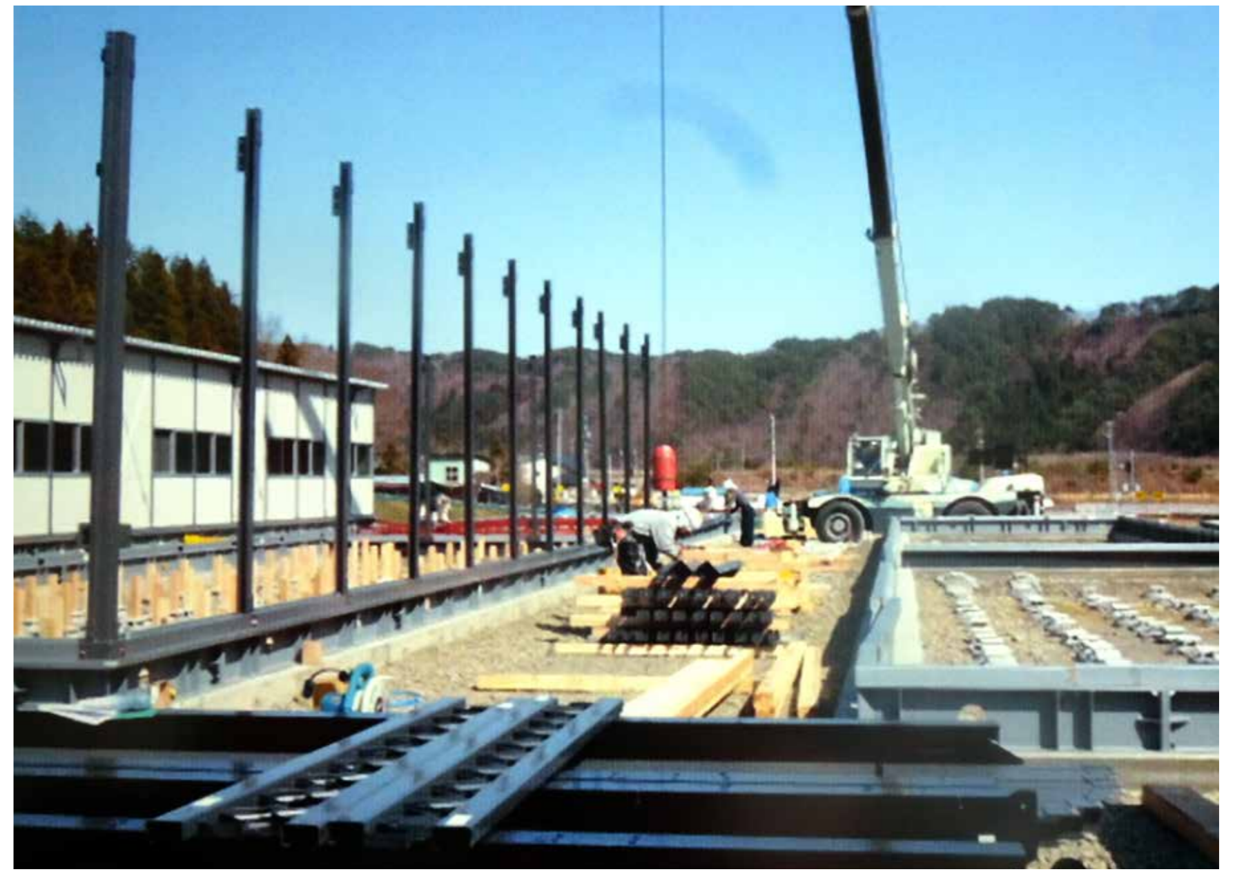
小本における仮設住宅の建設が始まった。岩泉町では小本、岩泉、小成の3か所に仮設住宅を建設した。小本仮設住宅は、そのうち最大規模のものである
