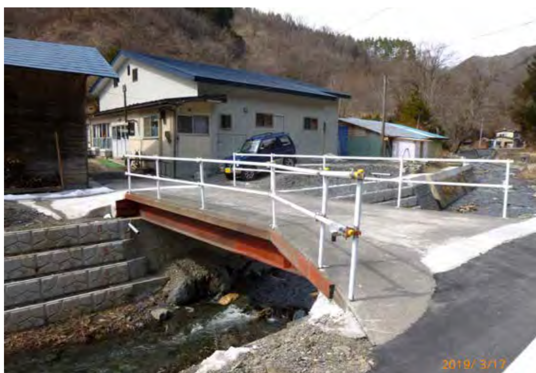
生活橋の工事も進んできた
