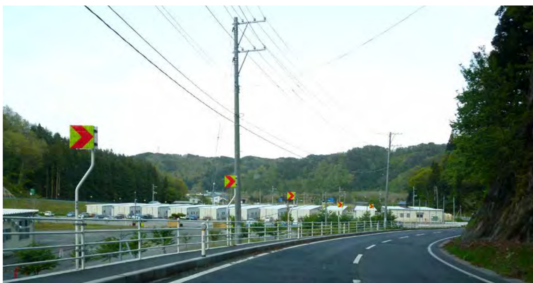
小本仮設住宅が完成した
