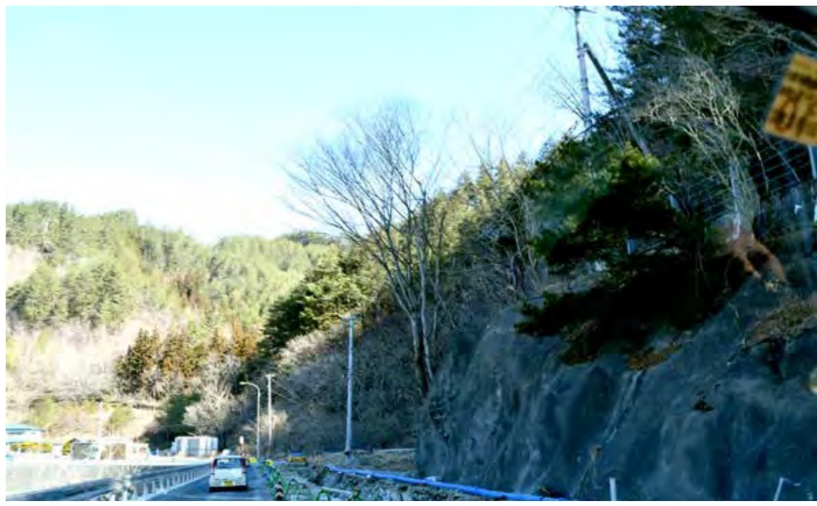
片側通行が続く小本川沿いの道路
