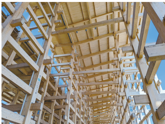
貫構造の大屋根リングを下から見上げる（撮影：小野 全子）
